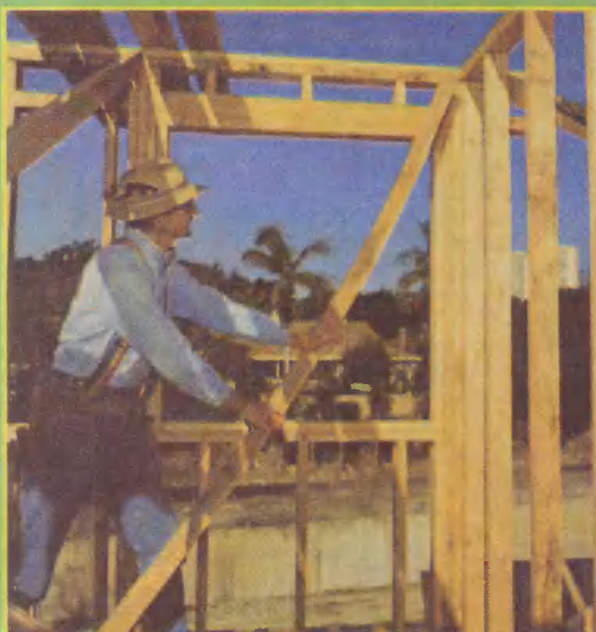
Рис. 3. Шаблоны для вырезания стропил легко изготовить и с ними работа пойдет быстрее. Уложите, как показано, все стропила на козлах; разметьте длину первого и последнего стропила в ряду; меловым шнуром разметьте остальные стропила, а затем с помощью шаблона — отвесные и уровневые линии на каждой стропильной ноге.
