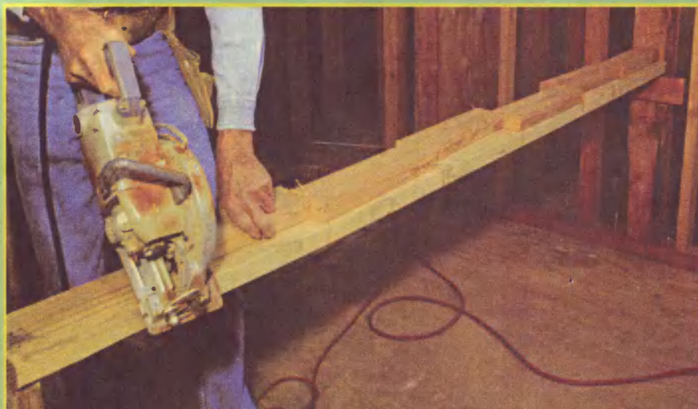
Фото 4. Деревянные заготовки быстрее напилить на размеченной доске. Своеобразный верстак с одной стороны лежит на внутренней перегородке, а с другой — поддерживается стойкой. Блоки пилят по линиям разметки, нанесенным с нужным интервалом.
