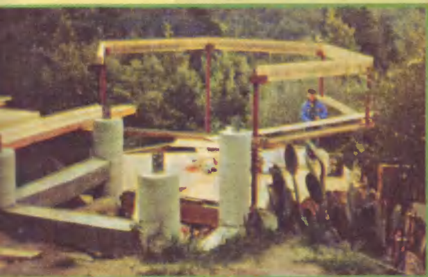
Сваи послужат опорой гаража. На заднем плане угловые стойки из стальных труб несут балки перекрытия сечением 100х300 мм. Фото с точки В на плане дома.
