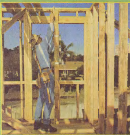
Фото 5. Крепим неточный уровень к отвесу. Чтобы проверить точность отвеса, отмечаем его положение на верхней и нижней обвязках стены, затем переворачиваем его и приставляем к отметкам. Если уровень неточен, корректируем его положение, вставляя регулировочный клин между уровнем и отвесом.
